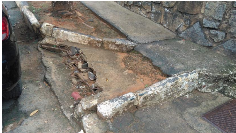
RUA DOMICIO MARTINS – TAMPA CAIXA DE DRENAGEM – DEMOLIR
