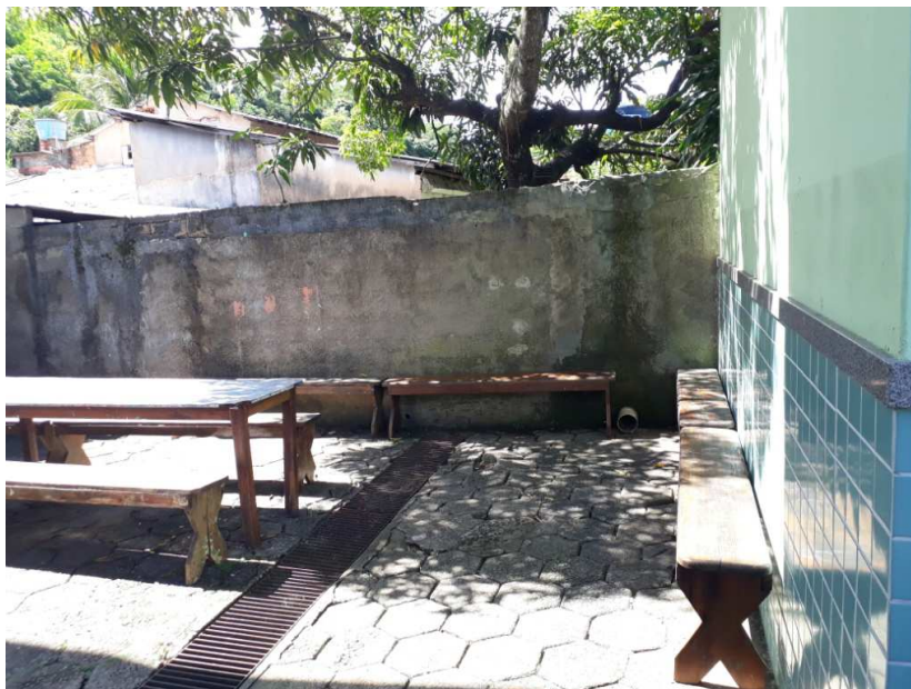
Espaço destinado para a construção da nova sala de aula.
